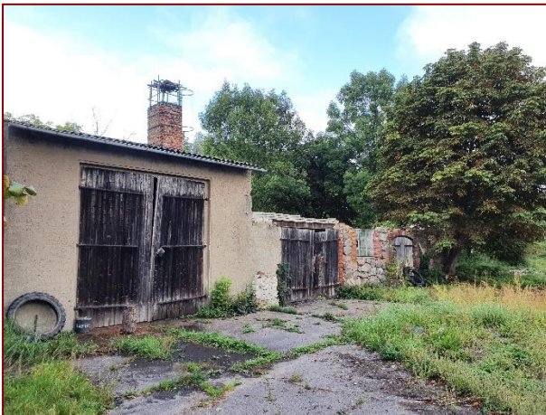
Abb. 2 – süd-west Blick auf Geräteschuppen aufgegebenes Storchennest auf Schornstein
