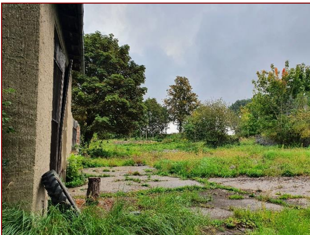
Abb. 4 – West Blick auf Hof mit Gebäuderesten im Hintergrund (Sockelreste)
