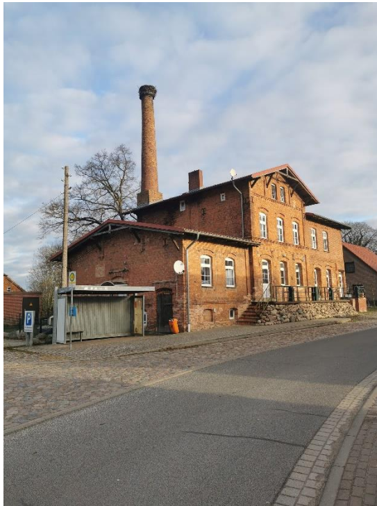
„ehemalige Molkerei“, nach Sanierung Mehrfamilienhaus
