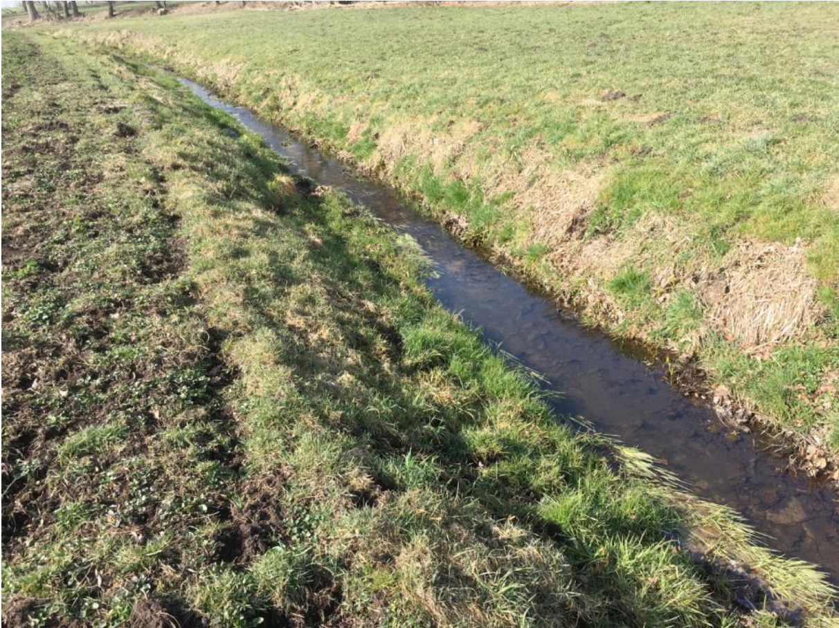
Abbildung 10: Graben nördlich des Großseggenriedes, Blickrichtung Süden, eigenes Foto 2022
