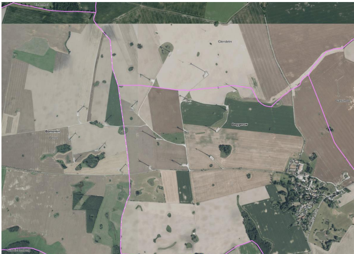
19 Windkraftanlagen an der Gemeindegrenze zur Gemeinde Borrentin nordwestlich von Beggerow (Luftbild) [Quelle: www.gaia-mv.de]
