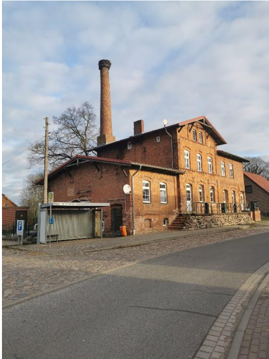
„ehemalige Molkerei“, nach Sanierung Mehrfamilienhaus
