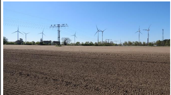
Südöstliche Blickrichtung auf die 110-kV-Leitung auf der Tf 2 mit angrenzender Wohnbebauung von Kletzin sowie dahinter liegendem Windpark Siedenbrünzow
