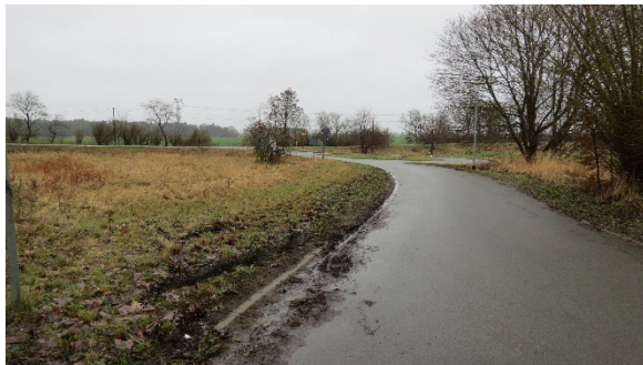
Blick nach Norden auf die gewidmete Straße „Leppin“ (Flst. Nr. 26) mit ihrem Anschluss an die B110
